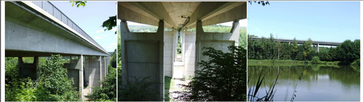
Figure 69. Différentes vues du Viaduc de l'Aisne par lequel les 3 cerfs suivis dans le massif de Verrières sont passés pour rejoindre le côté nord de l'autoroute A4.
